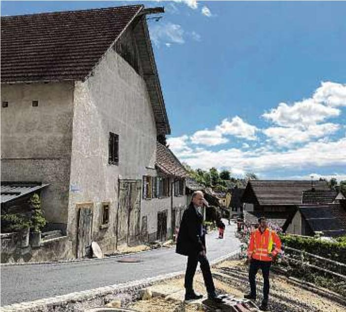
**Nachdem im Juni letzten Jahres** mit der Sanierung der Gehrenstraße in Zimmerholz begonnen werden konnte, wurde am vergangenen Montag die Tragschicht im zweiten Sanierungsabschnitt eingebracht. Bis zum Eintrag der Deckschicht in drei Wochen erfolgen die Hofangleichungen und weitere Restarbeiten. Bürgermeister Johannes Moser und Tiefbauingenieur Thorsten Frank freuen sich über ein baldiges Ende der Baumaßnahme.
